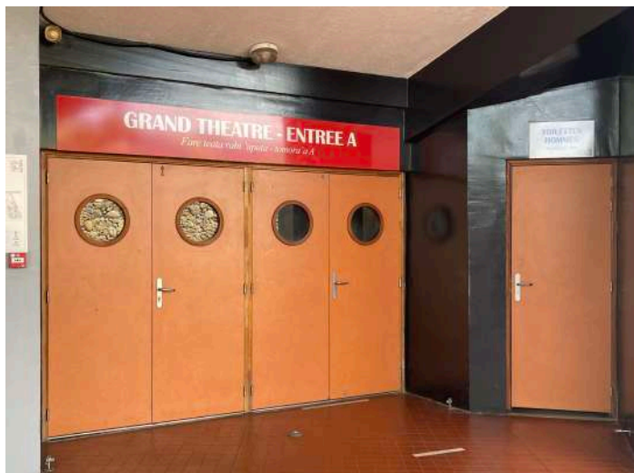
Entrée A + toilettes
