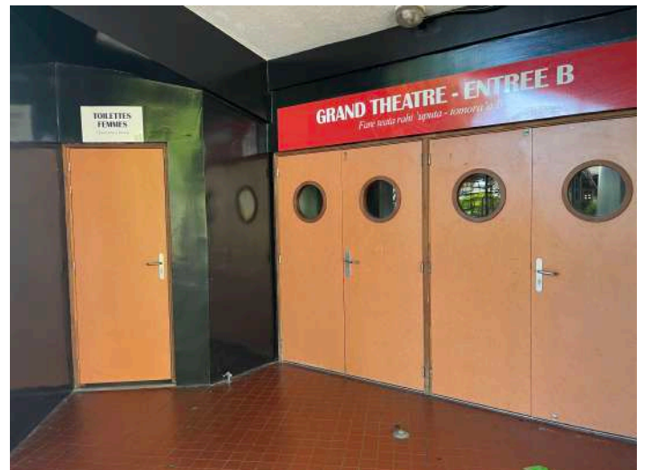
Entrée B + toilettes
